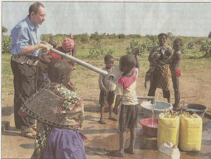
WASSER fließt wieder nach der Reparatur des Dorfbrunnens, für den Robert Mattheus und sein Team gesorgt haben.
